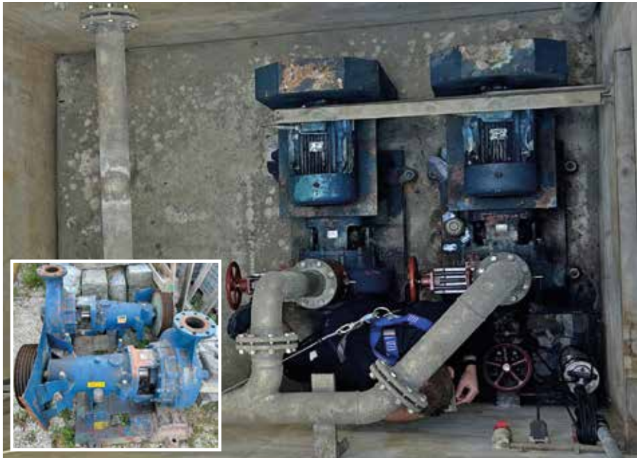
5 Meter tiefer Pumpenschacht
