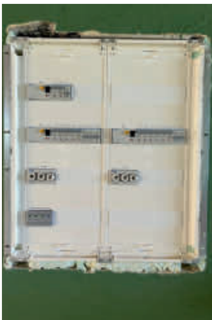
Sicherungsschrank – alt
