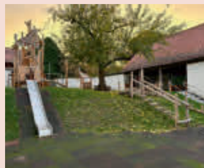
Neubau des Spielplatzes im Kindergarten
